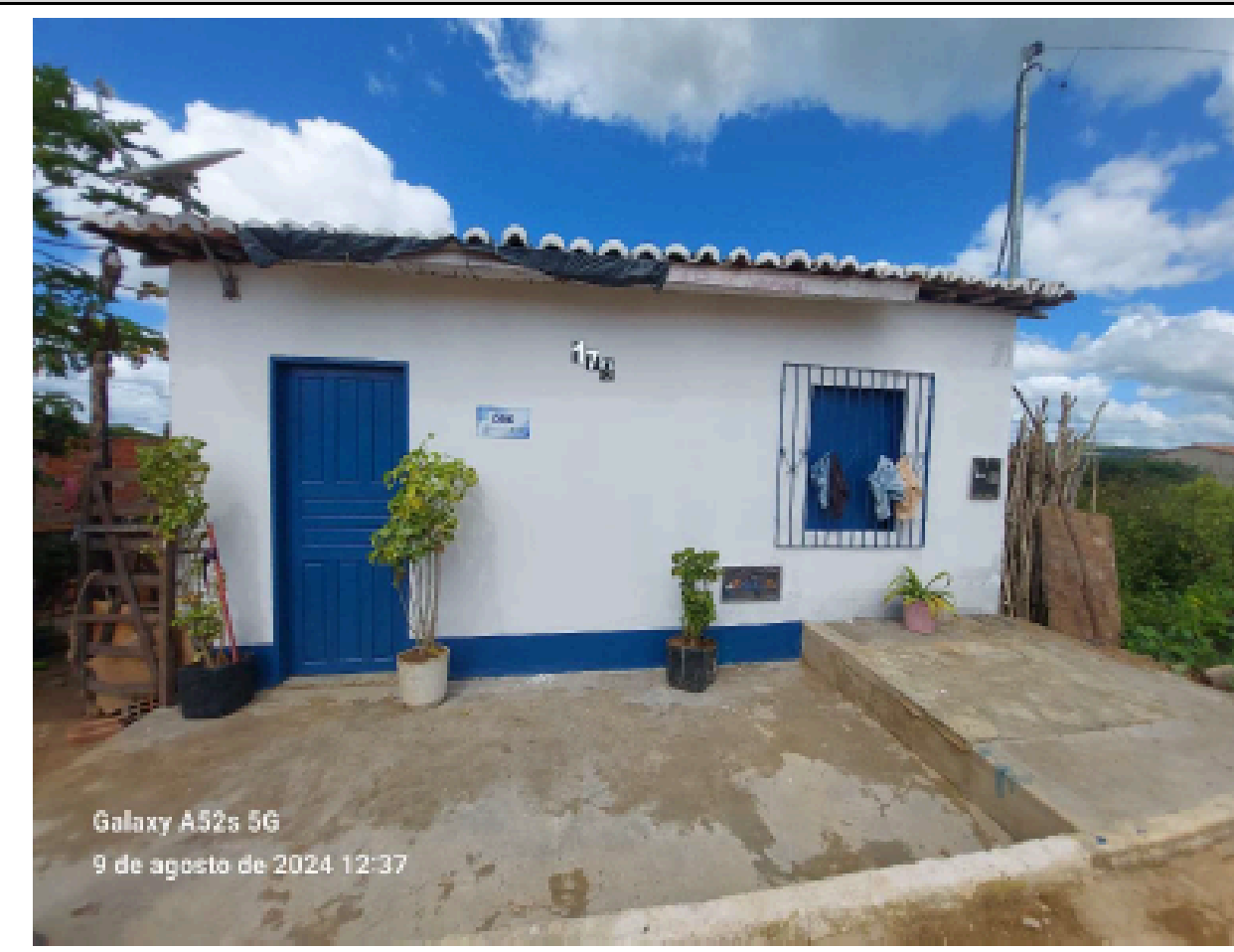
FACHADA FRONTAL DEPOIS
