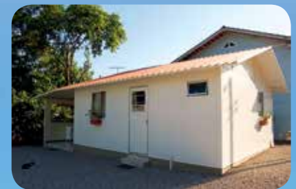
Casa modular reduz em 90% o tempo de execução da obra
