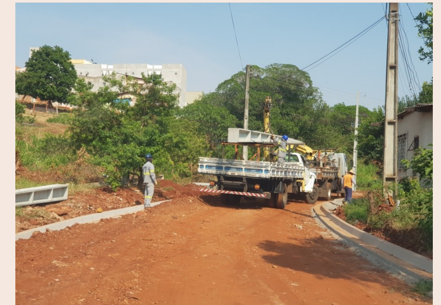
Postes no meio da rua
