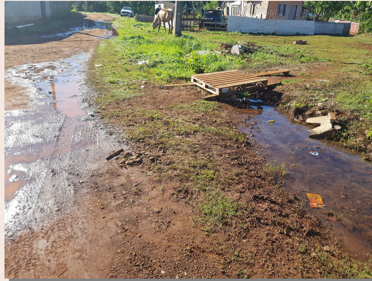
Desafio: Córrego alagando a Rua
