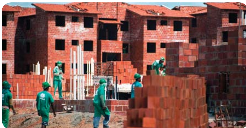
6.600 unidades habitacionais estão sendo construídas
