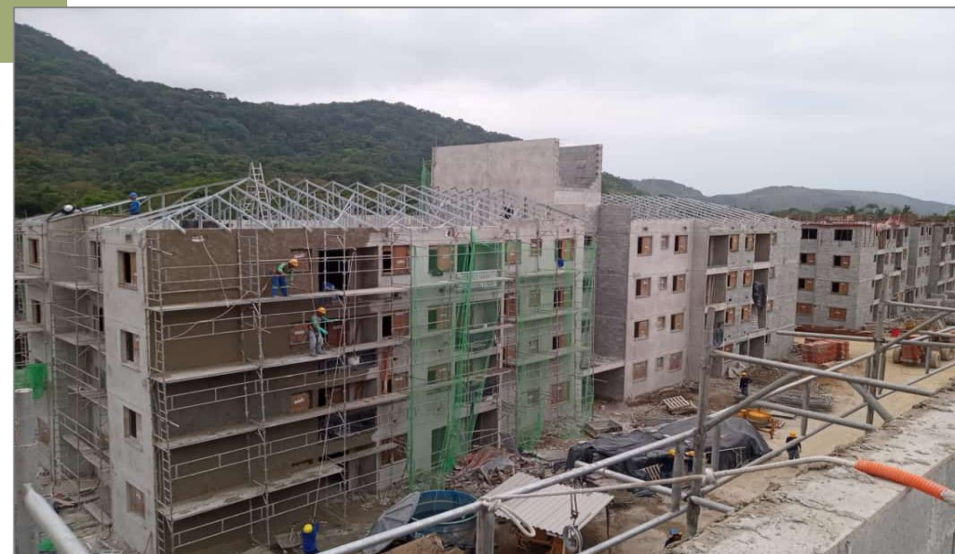
OBRAS EM ANDAMENTO
