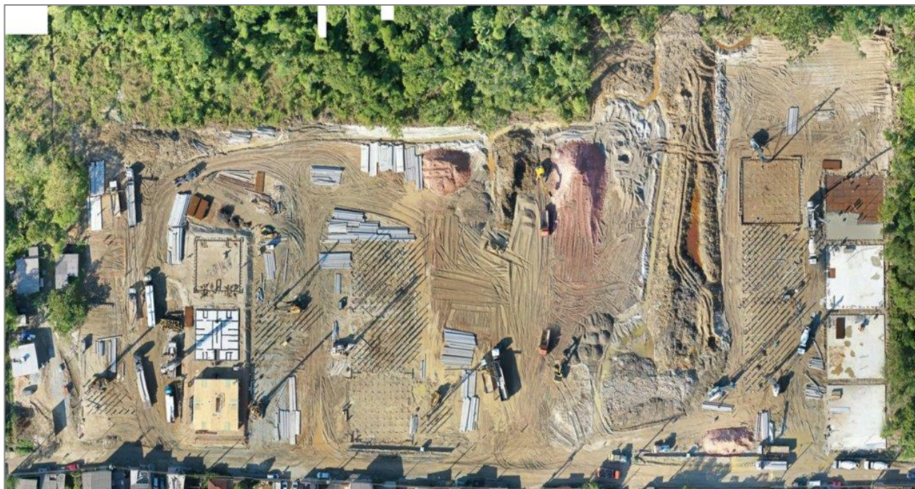
OBRAS EM ANDAMENTO
