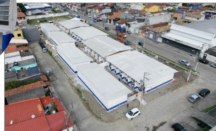
OBRA FINALIZADA EM MAI/23
