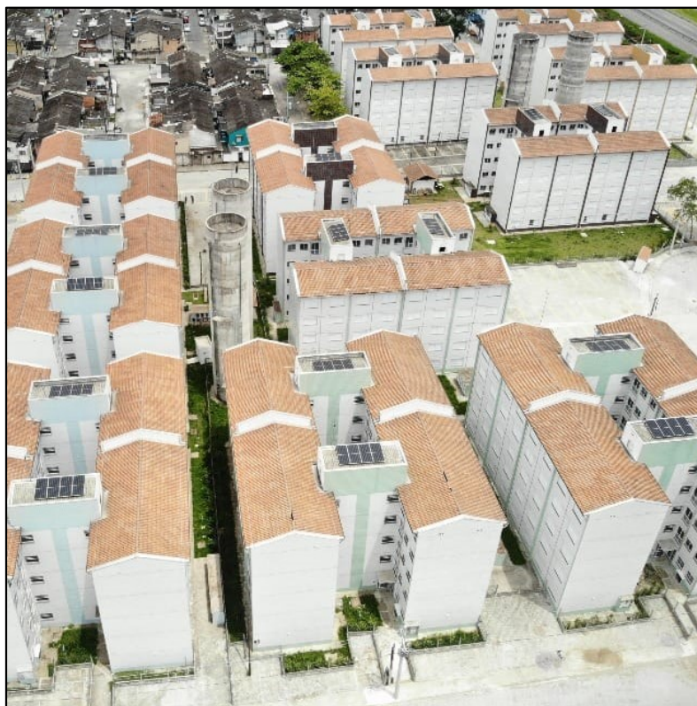
Imagem do Conjunto Habitacional Tancredo Neves III - placas fotovoltaicas (Fonte: Arquivo COHAB-ST) .
