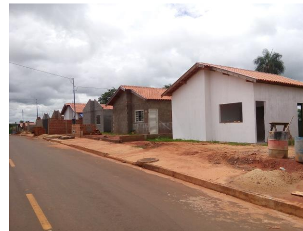
Autoconstrução em andamento com coberturas
