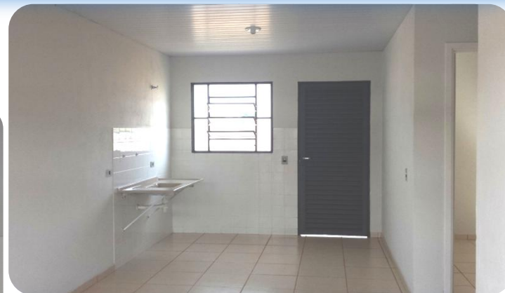
Forro de PVC em todos os cômodos
