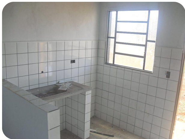
Revestimento de parede
