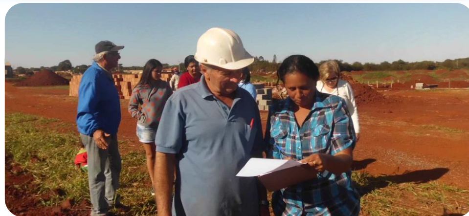
Vistoria da comissão de acompanhamento da obra
