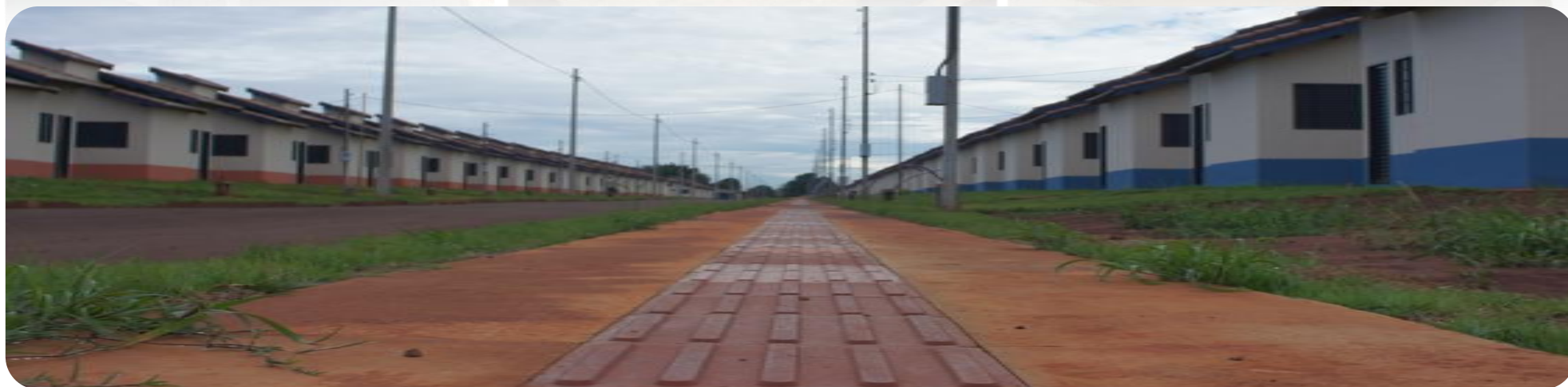
Passeio público com implantação de piso tátil
