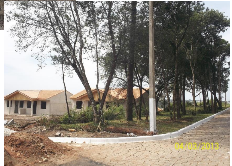
MORADIAS JERIVÁ – OBRA DAS CASAS
