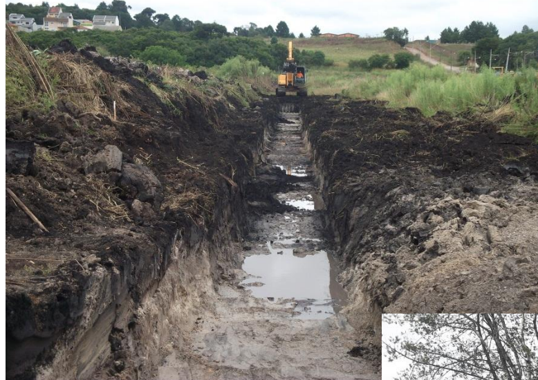
MORADIAS JERIVÁ – OBRA INFRAESTRUTURA (DRENAGEM)
