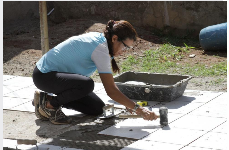
Moradora capacitada pelo programa e empregada nas obras do empreendimento
