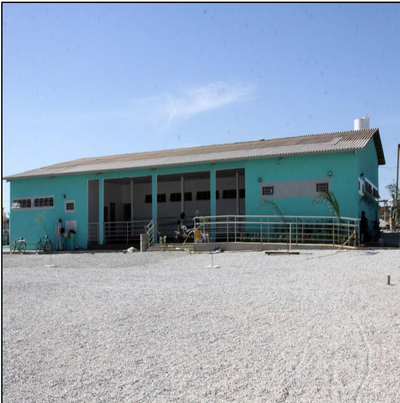
UDEP do Residencial Real Conquista – 440 m 2 de área construída
