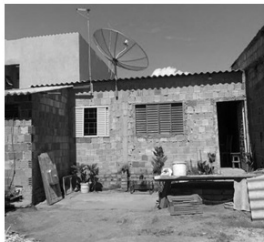
PAT - SHSN Tr3 Posto de Assistência Técnica
