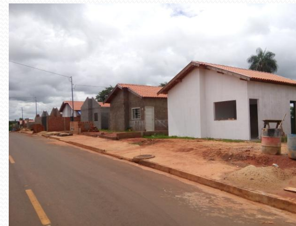
Autoconstrução em andamento com coberturas
